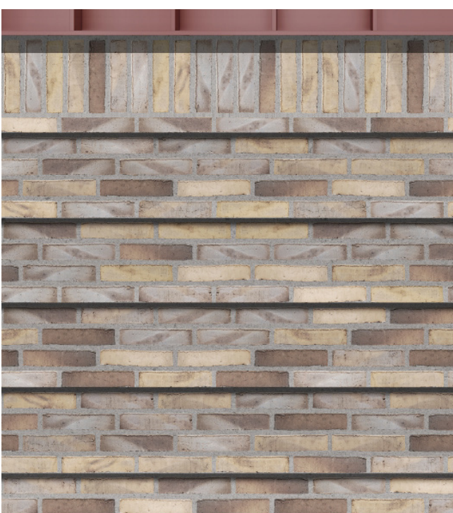
Reginehøj 21-29 Løberforbandt med udtrukne skifter
