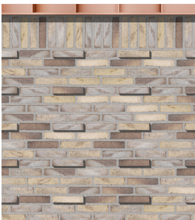
Reginehøj 11-19 Løberforbandt med udtrukne sten
