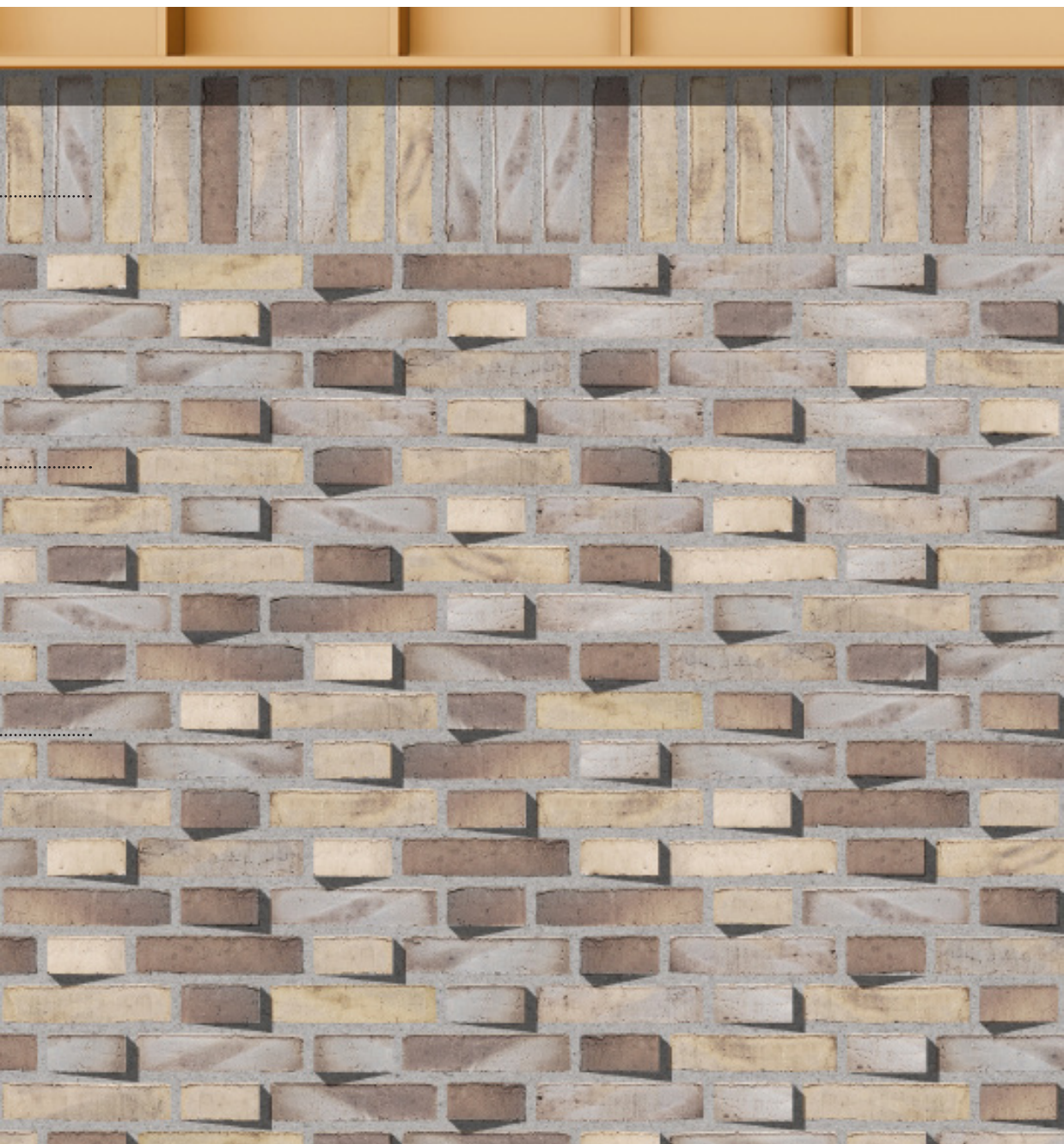
Reginehøj 21-29 Løberforbandt med udtrukne skifter
